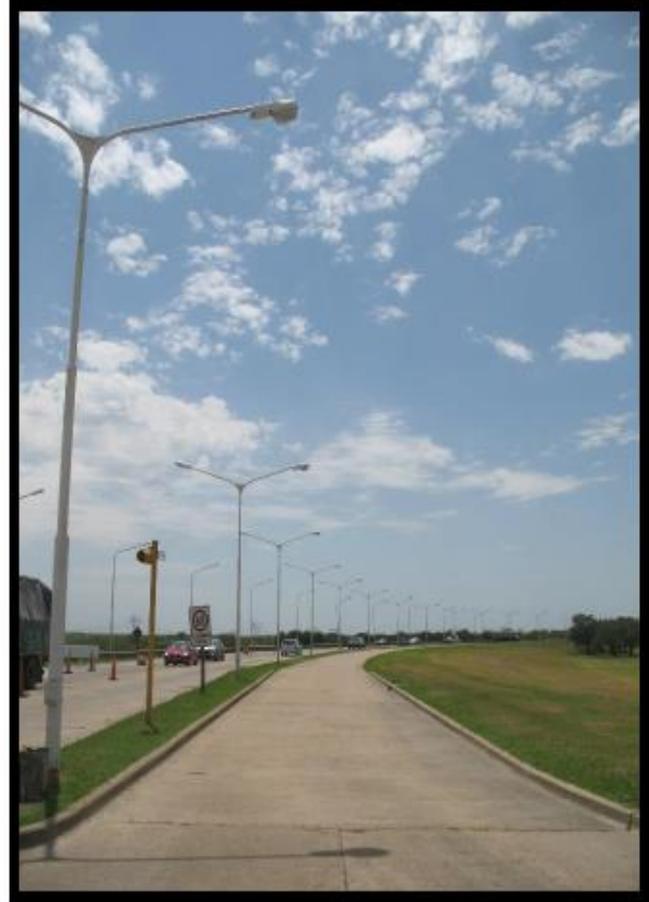
Fig. 9 Luminaria N°2 – Zona 4
