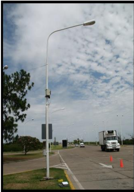
Fig. 4 Luminaria N°1 – Zona 2
