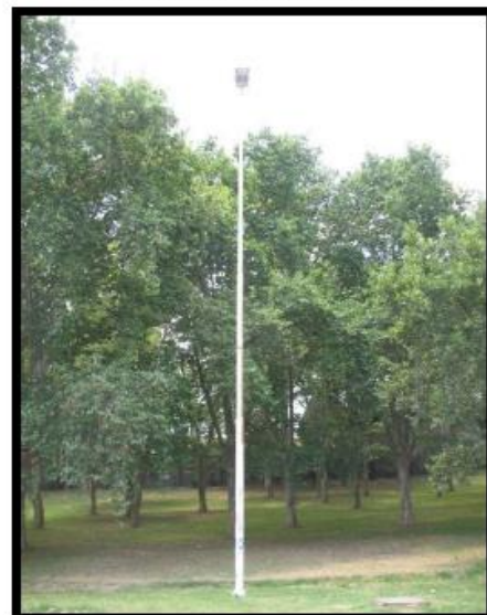
Fig. 15 Luminaria N°4 – Zona 8
