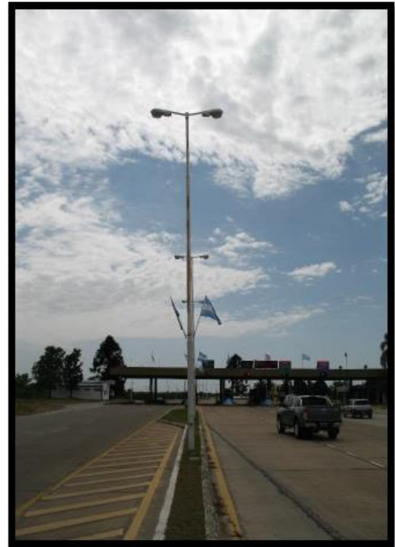
Fig. 5 Luminaria N°2 – Zona 2
