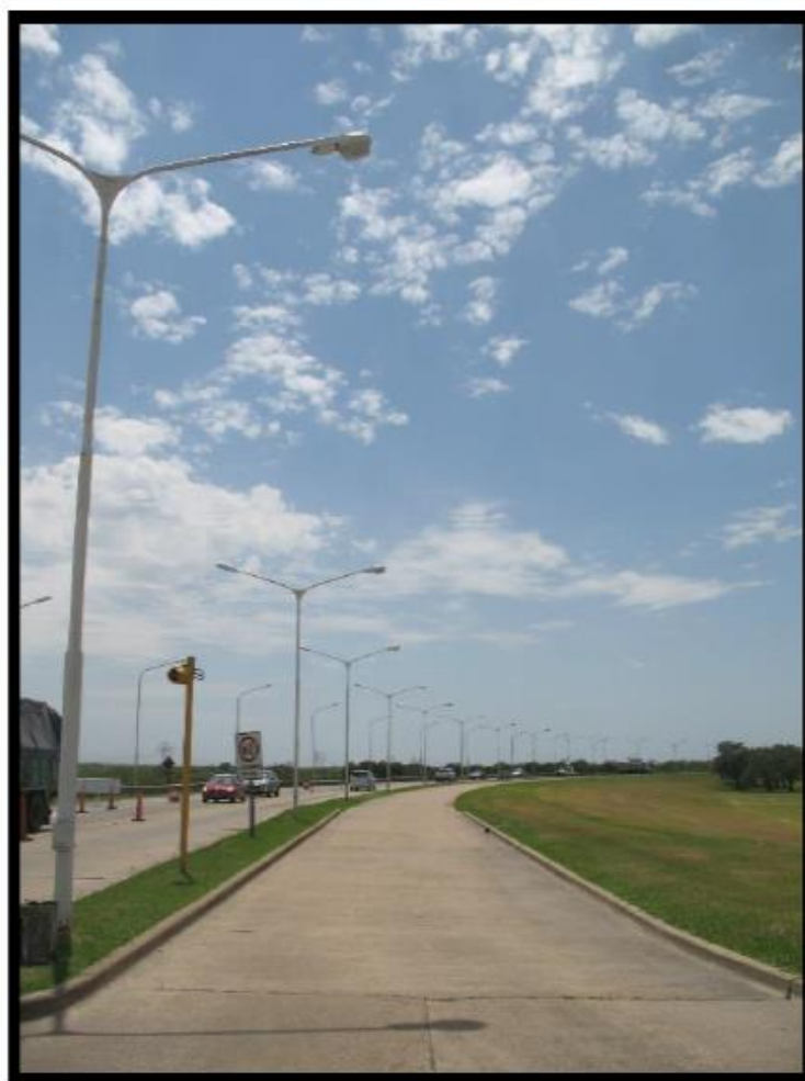
Fig. 9 Luminaria N°2 – Zona 4
