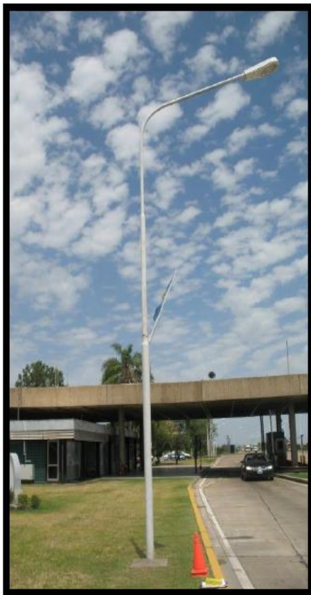
Fig. 6 Luminaria N°1 – Zona 3
