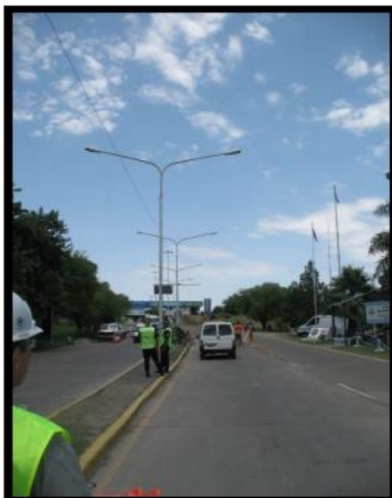
Fig. 14 Luminaria N°3 – Zona 8
