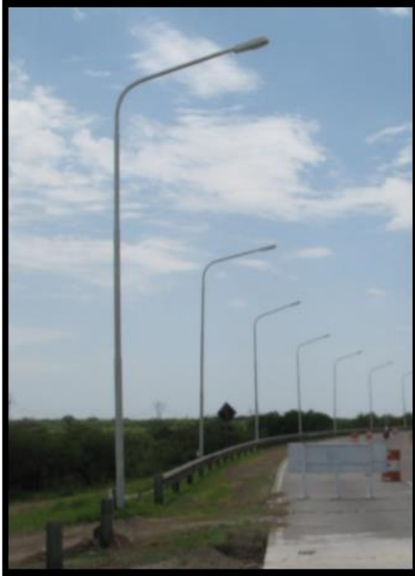
Fig. 8 Luminaria N°1 – Zona 4
