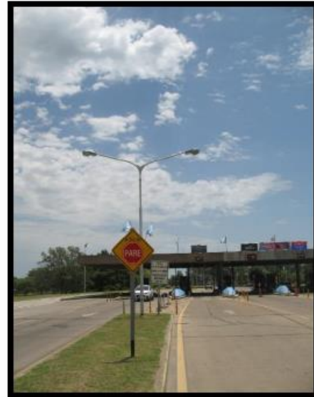
Fig. 13 Luminaria N°2 – Zona 8
