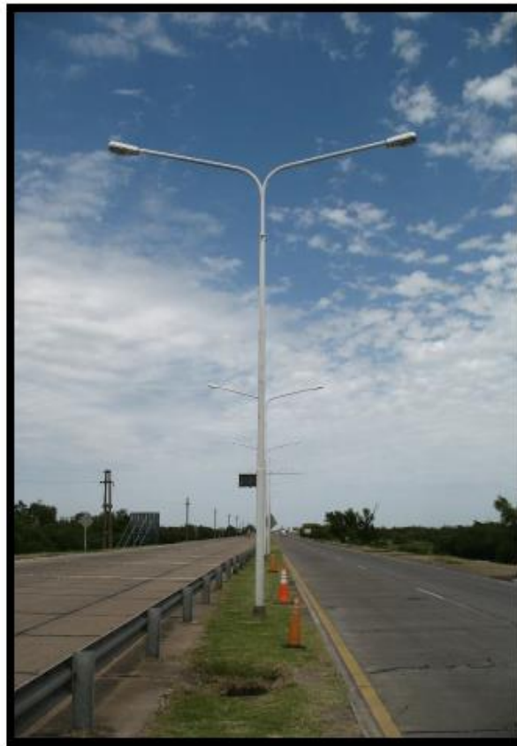
Fig. 3 Luminaria N°1 – Zona 1
